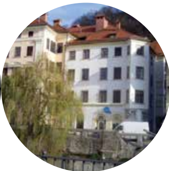
Un exemplu de clădire după renovare. Sursa: GIVO, d.o.o., Ljubljana
