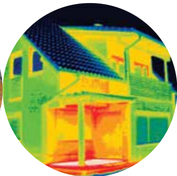
Imaginea prezintă scanarea cu termoviziune, care ne ajută să identificăm și să evaluăm pierderile de căldură ale clădirii.
